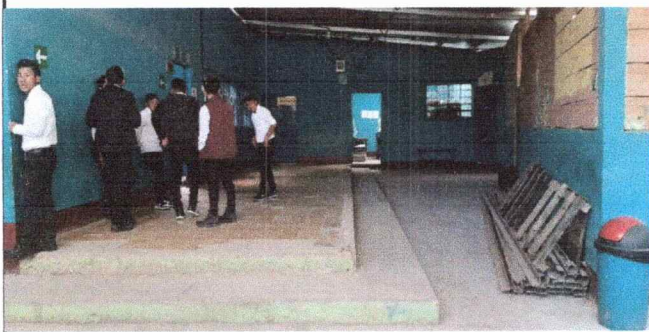
Foto 5: REPARACION DE PLANCA DE CONCRETO DE PATIO
