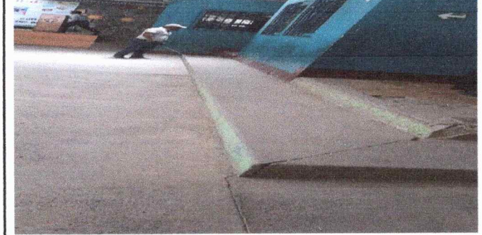
Foto 6: SUSTITUCION DE PISO
